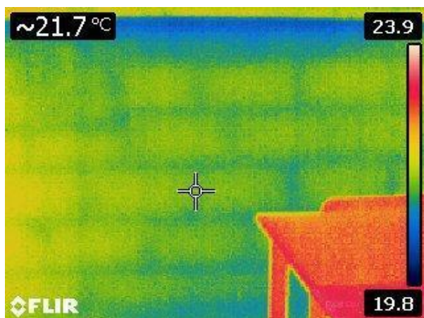
Figura 1.2 – Immagine termografica muro perimetrale
